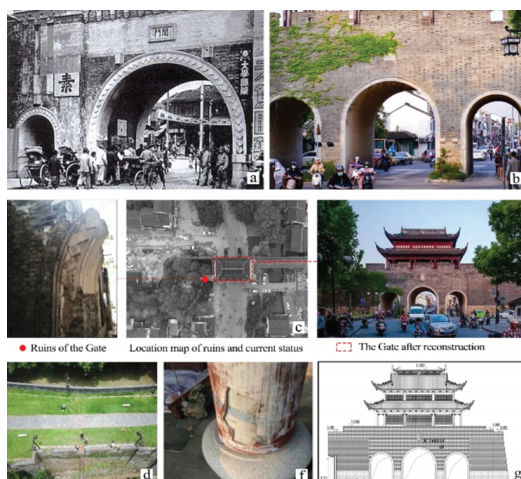
图2: 阊门: 重建前照片 (a); 重建后照片 (b); 遗址及现状位置图 (c); 使用探地雷达 (d); 钢筋混凝土结构的柱子 (f); 重建后的立面 (g)
