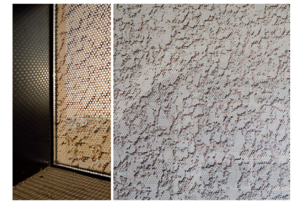
图 6：丝网印刷玻璃透光效果及细节（图片来源：左、右由田方方摄影；中由扬天周摄影）
