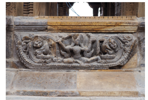
图 7：重新使用了历史元素，仅部分更换了严重损坏的零件——在这种情况下，顶部轮廓被当地石匠制作的石头凹痕替换（维也纳应用艺术大学保护研究所，2018 年）
